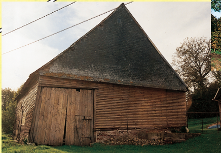
Grange à Rouvroy-sur-Serre
